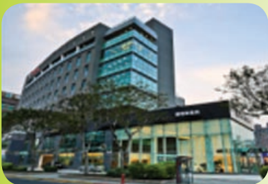
國都陽明所1樓採用玻璃專用隔熱塗料
